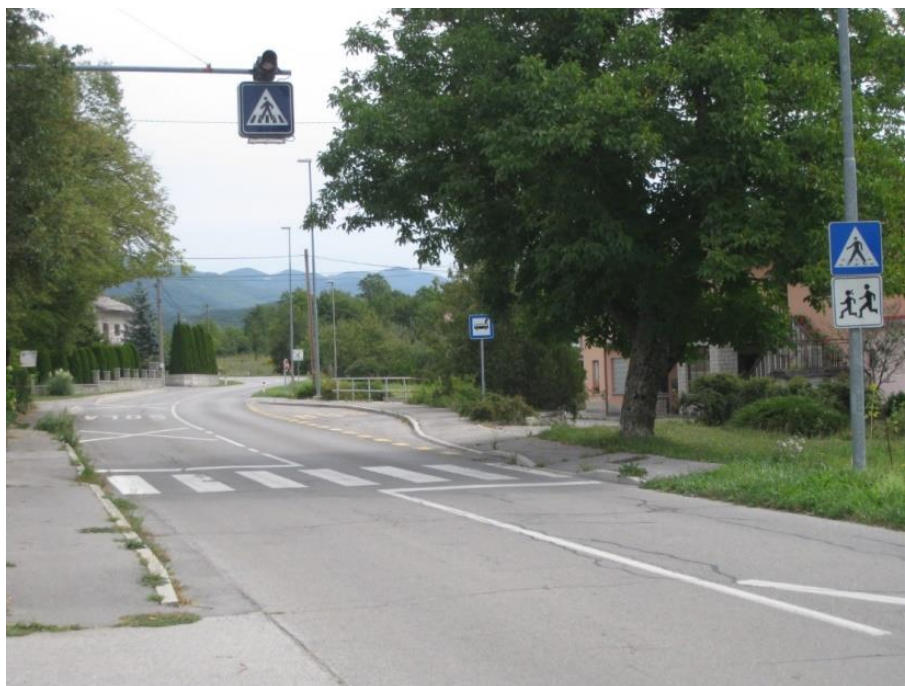
Slika 21: Prehod za pešce preko regionalne ceste Ilirska Bistrica – Zabiče
